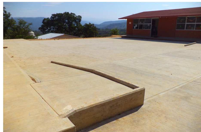
EPI FRANCISCO I. MADERO EL COCO SANTA CATARINA, S.L.P. CONSTRUCCION DE UN AULA DIDACTICA Y REHABILITACION GENERAL DEL PLANTEL
