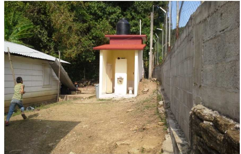
EP MIGUEL BARRAGAN TOTOATL COXCATLAN, S.L.P. REHABILITACION GENERAL DE LA INFRAESTRUCTURA DEL PLANTEL EN LOS EDIFICIOS A, B Y C
