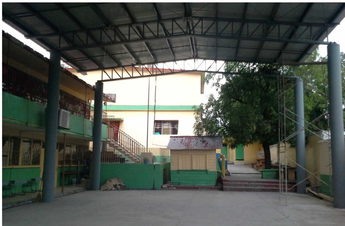
E.P. VICENTE GUERRERO BARRIO LAS LOMAS CIUDAD VALLES, S.L.P. CONSTRUCCION DE CUBIERTA DEL PATIO CIVICO Y REHABILITACION DEL EDIFICIO "B".
