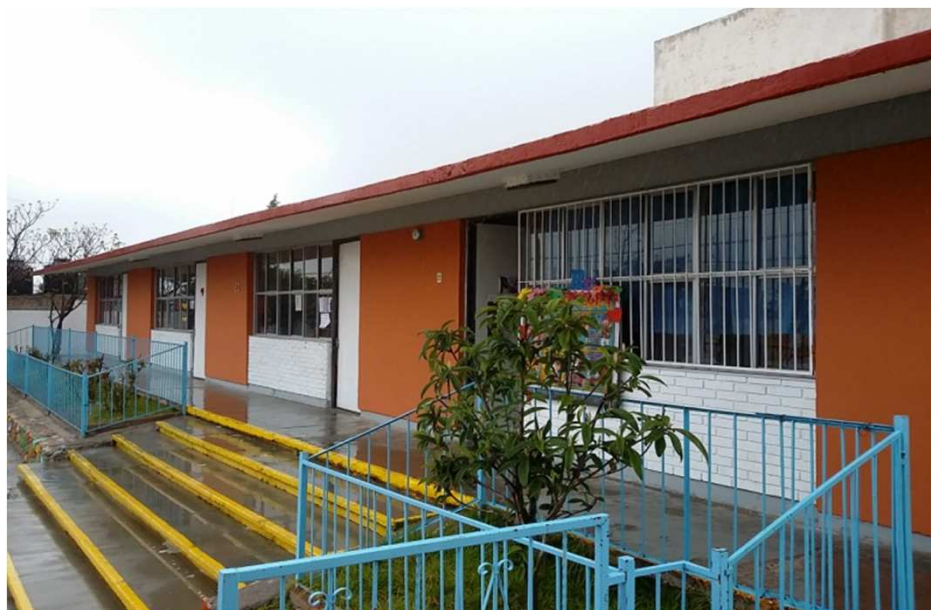
JN ROSAS DE LA INFANCIA CLAVELLINA CHARCAS REHABILITACION DE UN MODULO DE SERVICIO SANITARIO
