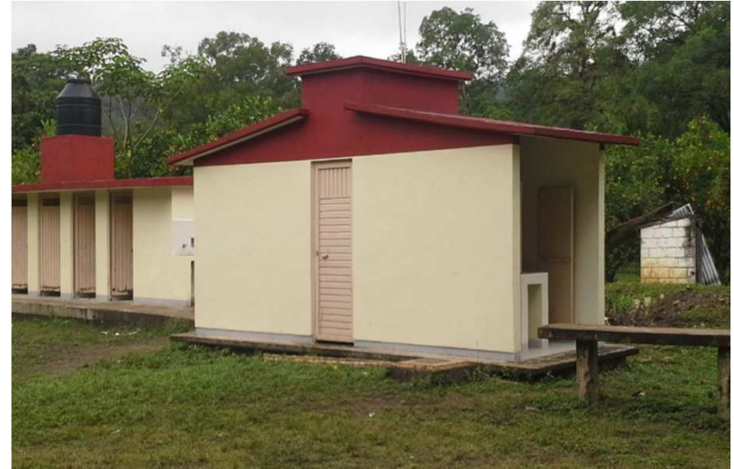
EP FRANCISCO GONZALEZ BOCANEGRA AJUATITLA COXCATLAN, S.L.P. REHABILITACION GENERAL DE LA INFRAESTRUCTURA DEL PLANTEL EN LOS EDIFICIOS B, C, D, E y F.
